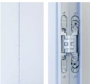
2. Schattenfuge 10 mm in Farbe der Trennwand, Verschraubung verdeckt
